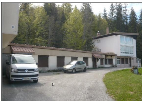
Ces immeubles ont été construits en matériaux traditionnels, charpente en bois, couverture en bac acier (la toiture du bâtiment 2 a été rénovée, celle du bâtiment 1 nécessite une rénovation).
